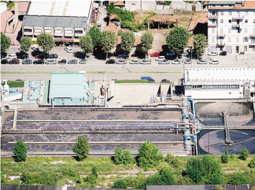
L'impianto di depurazione di viale Innocenzo
